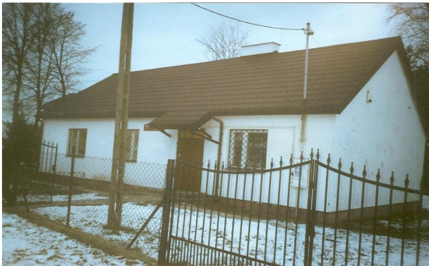
Budynek szkolny w Beniaminowie, stan obecny 15
